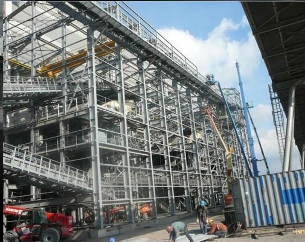
**CARSID = Gaines de dépoussiérage Ø4800 lg total 330m et 13 Hottes de 13,5m sur 5,5m hauteur 6,5m**
